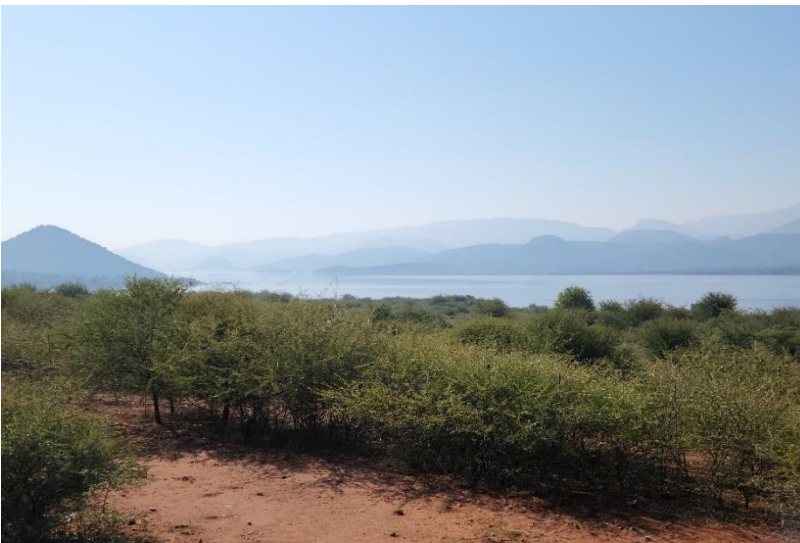
De Hoop Dam
